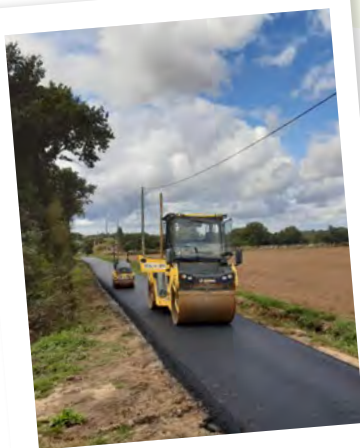
10 septembre Travaux de réfection de la voirie communale (Mairie de Rostrenen & Entreprise SPTP)
