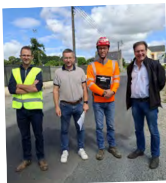
8 juillet Réception des travaux sur les réseaux d'eaux des rues Marcel Sanguy & des Martyrs (SMAEPKBA & Mairie de Rostrenen)
