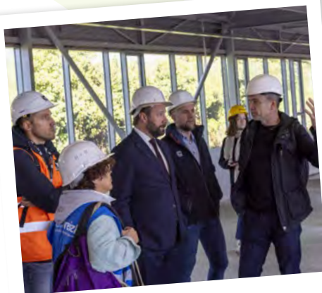
30 septembre Visite des chantiers du nouveau gymnase et des ateliers au Lycée des Métiers Rosa Parks (Région Bretagne, Mairie de Rostrenen & Sembreizh)
