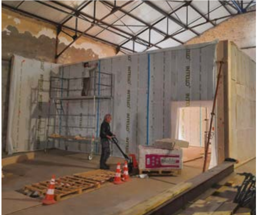
L'entreprise Arnoud Jagoury de Plouguernevel travaille, avec plusieurs entreprises du territoire, à la réhabilitation du Garage Duro.
