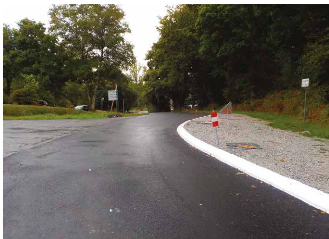
Aménagements de sécurité routière à Pont Bonen
