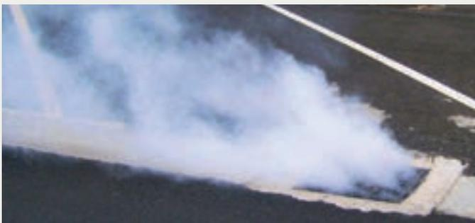
Dans le cadre du schéma directeur d'assainissement collectif, la société IRH va procéder à des tests à la fumée sur le réseau d'assainissement entre le 19 et le 23 avril.
